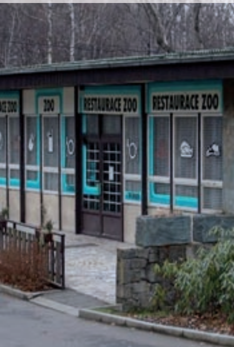
Samoobslužná restaurace před demolicí Self - service restaurant before demolition
