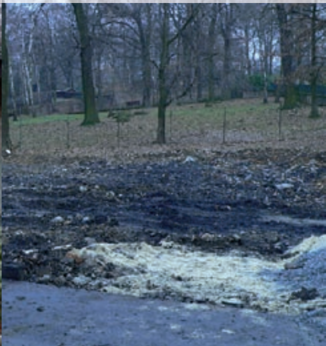
Na místě po zdemolované restauraci vyroste nové Návštěvnícké centrum A new visitors' centre will be built at the place of demolished restaurant
