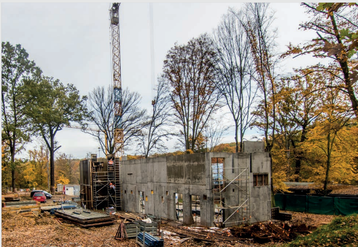
Stavba expozičně-chovatelského zařízení pro makaky lví ( Macaca silenus ) / Construction of an exhibit for lion-tailed macaques
