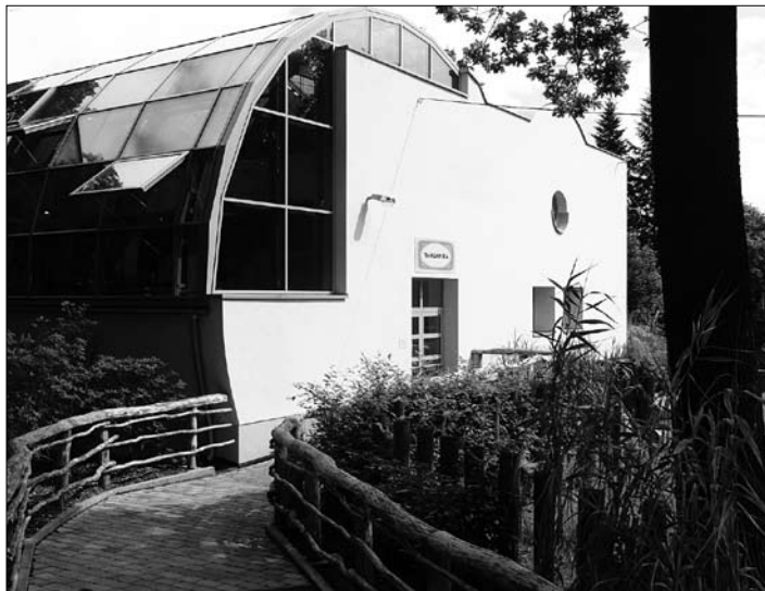
I hroši se dočkali lepšího bydlení – nově zrekonstruovaný pavilon
