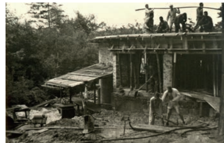
Stavba původního pavilonu primátů
