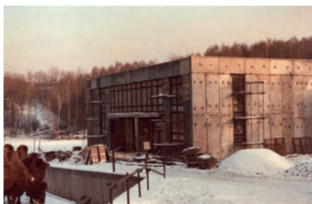
Výstavba pavilonu vodních ptáků, dnes přestavěn na Pavilon evoluce
